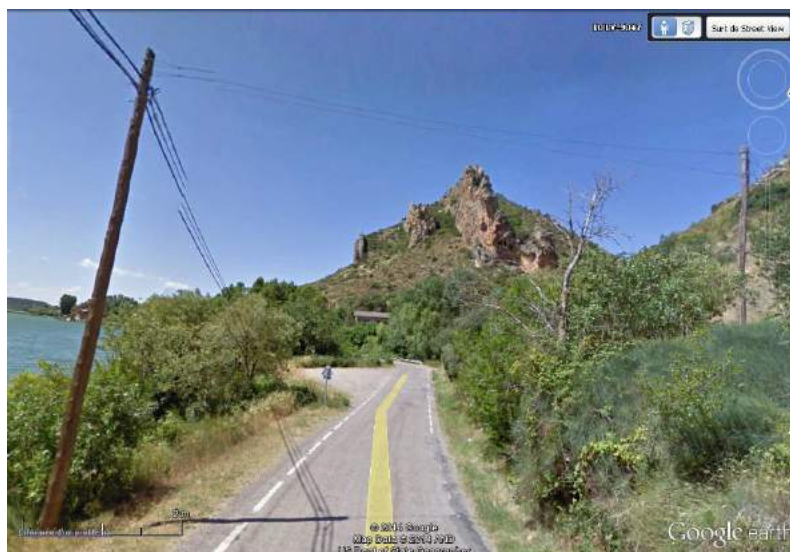
Poste con tensor que cruza la carretera
