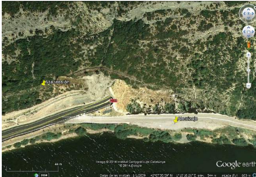
Aterrizaje y situación cable alta tensión
