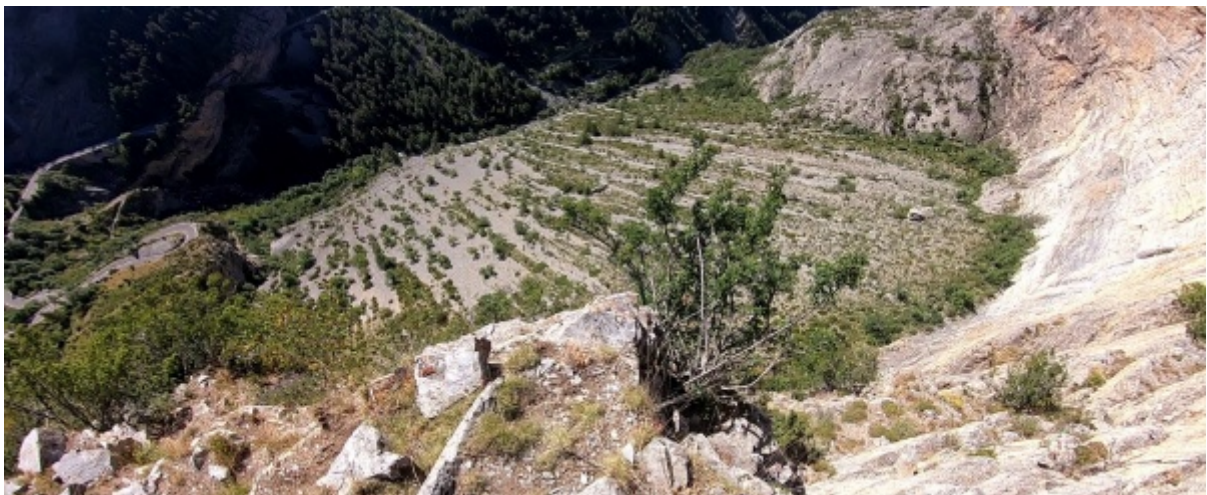
Vue de l'exit
